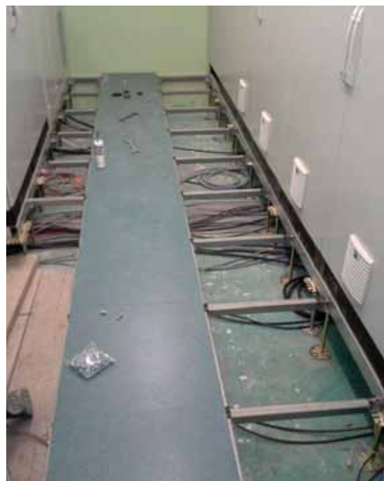
Das Umspannwerk Untersiebenbrunn wurde mit 470 m 2 Schaltwartenboden ausgestattet
