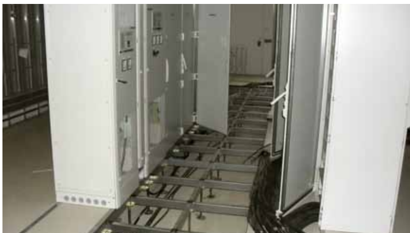
Das Umspannwerk Untersiebenbrunn wurde mit 470 m 2 Schaltwartenboden ausgestattet
