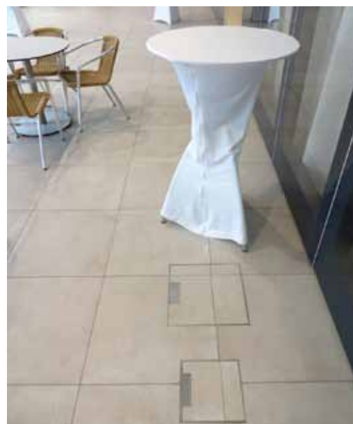
Das Congress Centrum Alpbach entschied sich für eine Installationslösung von Rowa-Moser mit rund 500 m estrichüberdecktem Kanalsystem UKR + Zubehör, Schwerlast-Kabelausslass-Kassetteneinheiten, Nivelliereinheiten sowie diversen Sonderkomponenten
