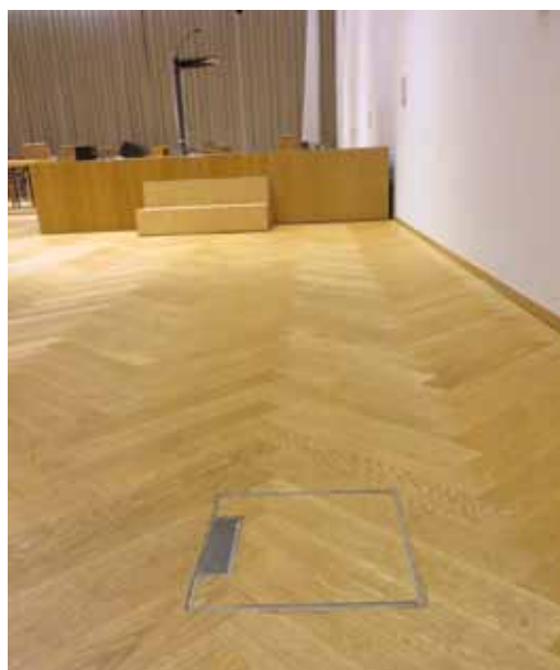
Das Congress Centrum Alpbach entschied sich für eine Installationslösung von Rowa-Moser mit rund 500 m estrichüberdecktem Kanalsystem UKR + Zubehör, Schwerlast-Kabelausslass-Kassetteneinheiten, Nivelliereinheiten sowie diversen Sonderkomponenten
