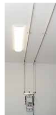
Im Röntgenraum kann zwischen Orientierungslicht und Licht mit hoher Beleuchtungsstärke einfach umgeschaltet werden
