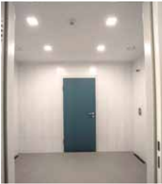
Für die WC- und Dusch-Anlagen der HTL Mössingerstraße wurden LED-Einbau-Downlights gewählt, die eine Einbautiefe von nur 26 mm haben
