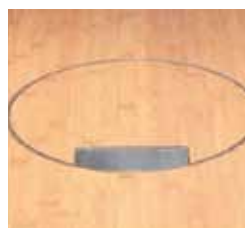
Das Bürogebäude Geisslinger wurde mit 280 Stück Edelstahlbodendosen rund Sonderhöhe 250 mm samt Zubehör von Rowa-Moser ausgerüstet
